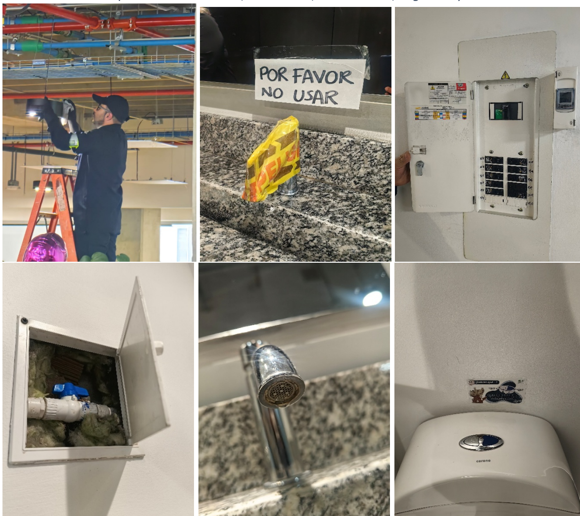
Ilustración 13 Inspección visual baños, luminarias, señalización, registros y tableros eléctricos
