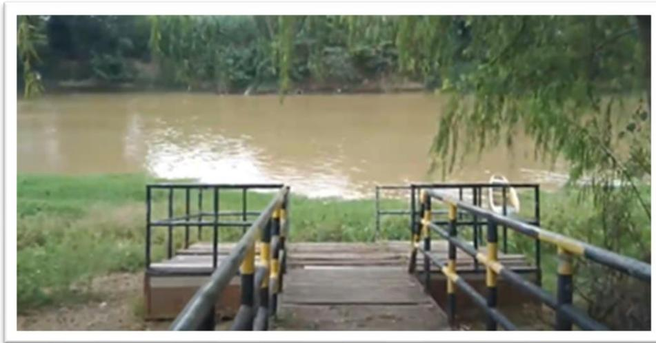
Ilustración 16. Zona de atraque, en abandono con deterioro en su piso.
