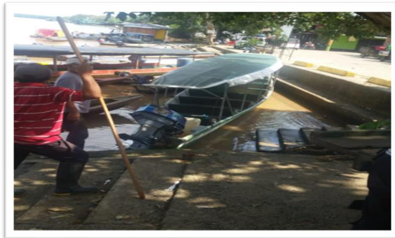
Ilustración 33. Escaleras del muelle de la plaza de mercado
