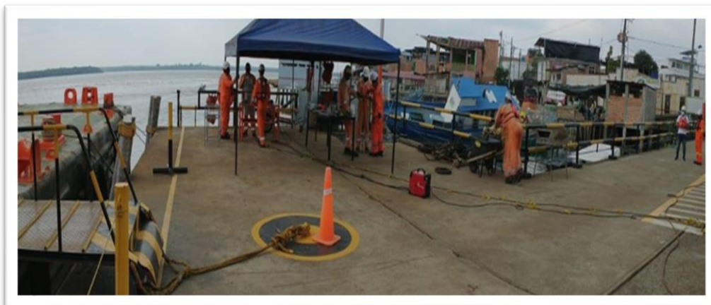
Ilustración 34. Muelle de la Gabarra
