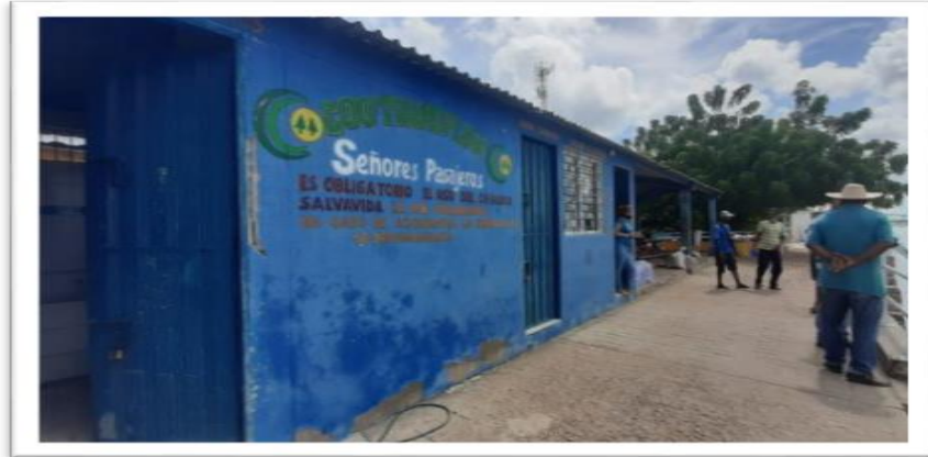
Ilustración 13 Oficina COOTRANSFLUSI, ubicada en el Malecón
