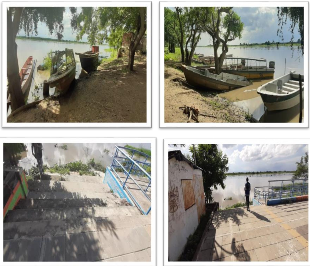
Ilustración 15. Embarcadero de Remolino
