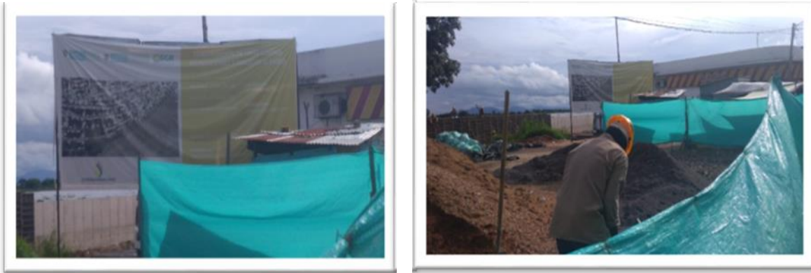
Ilustración 4 Construcción Muelle Turístico El Banco
