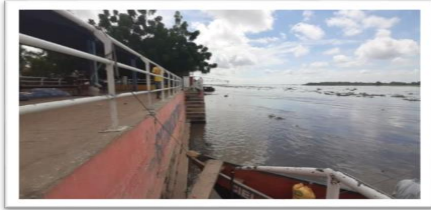
Ilustración 10 Embarcadero Sitio Nuevo - infraestructura
