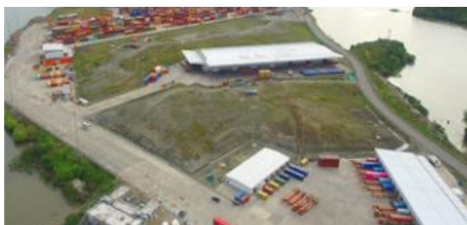
Figura 7: Vista aérea de bodegas extraída de https://www.puertoaguadulce.com/es/
