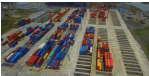
Figura 8: vista aérea de los patios Extraída de https://www.puertoaguadulce.com/es/nue
