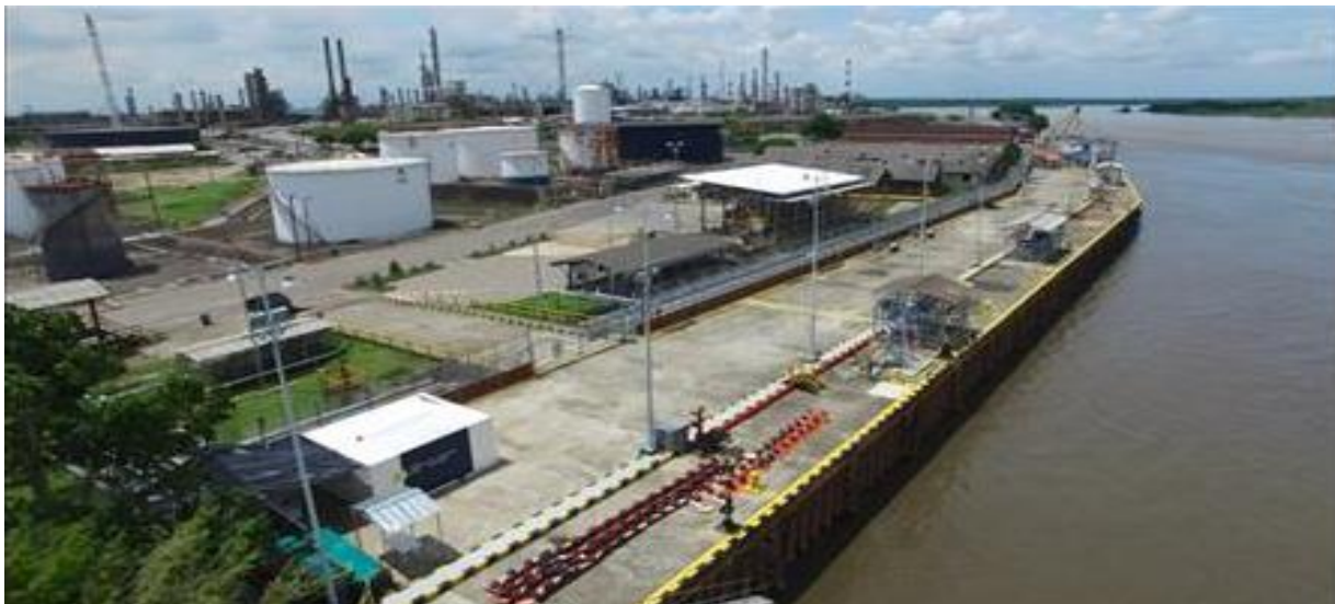
Figura 3: Vista del Muelle Nuevo Ecopetrol www.supertransporte.com
