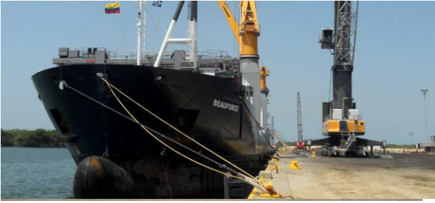
Figura 6: Muelle Extraído de: http://puertopimsa.com/
