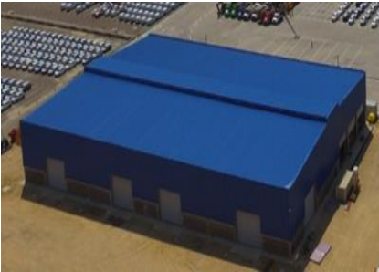
Figura 5: Bodega Suministrada por Puerto Bahía
