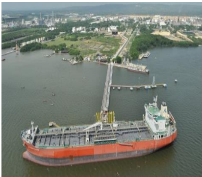
Figura 3: servicios prestados a la nave
