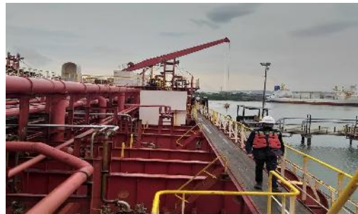
Figura 6: Instalaciones Extraída de: www.vopak.com
