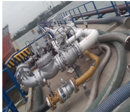
Figura 7: área de operaciones en la zona de atraque Suministrada por Dexton S.A
