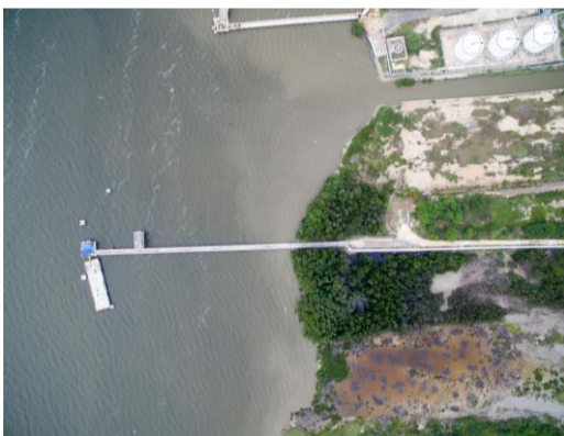
Figura 2: Canal de acceso al puerto
