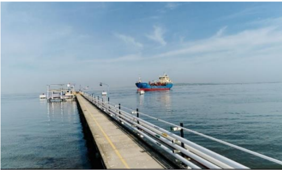
Figura 3: pasarela de acceso
