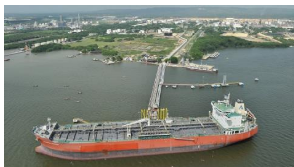
Figura 2: Canal de acceso al puerto extraída de https://www.ani.gov.co/
