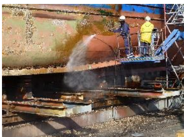
Figura 3: Servicios prestados a la nave
