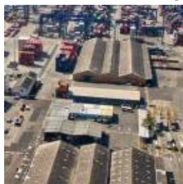
Figura 6: bodegas y cobertizos Extraída de portalportuario.cl
