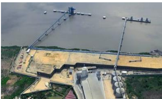
Figura 10: muelles Extraída de http://zona572.com/~riverport/
