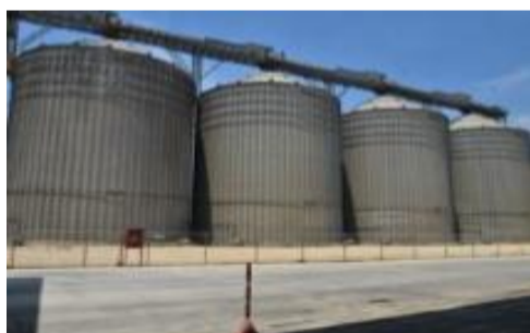
Figura 7: silos Extraída del manual técnico de operaciones
