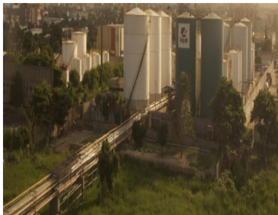
Figura 3: Servicios prestados a la nave Extraído de https://www.vopak.com/
