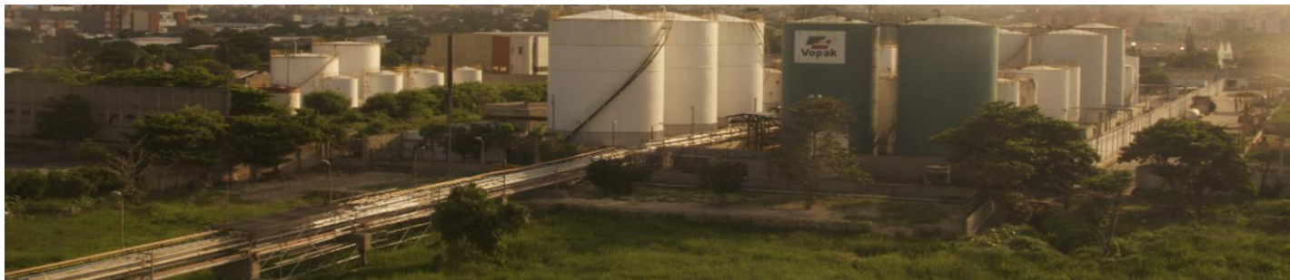
Figura 5: Tanques de almacenamiento.
