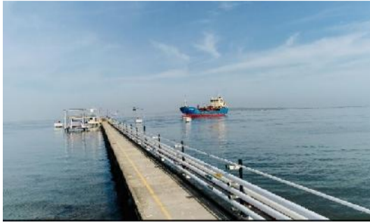
Figura 3: pasarela de acceso
