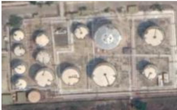
Figura 5: tanques de almacenamiento
