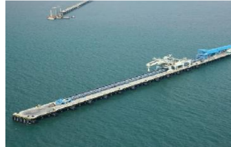
Figura 6: Vista aérea del muelle
