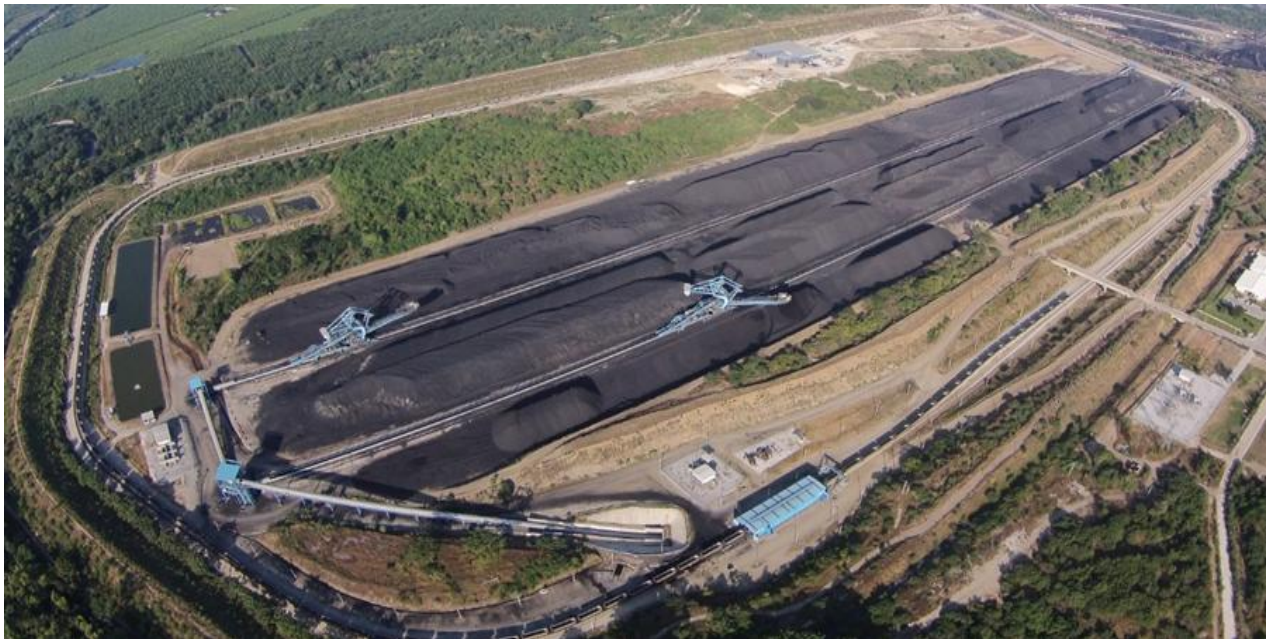
Figura 5: vista aérea de los patios de almacenamiento
