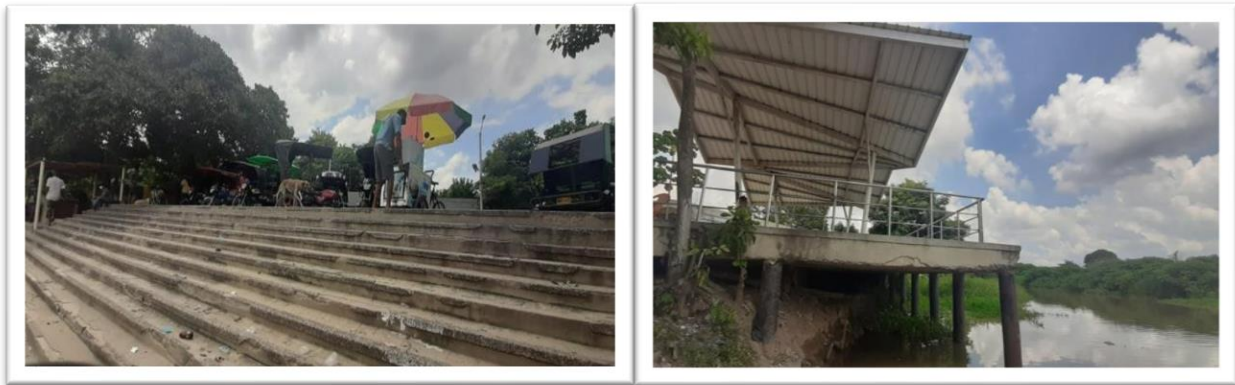
Ilustración 5, Construcción y Estructuración del Malecón de Sabanagrande
