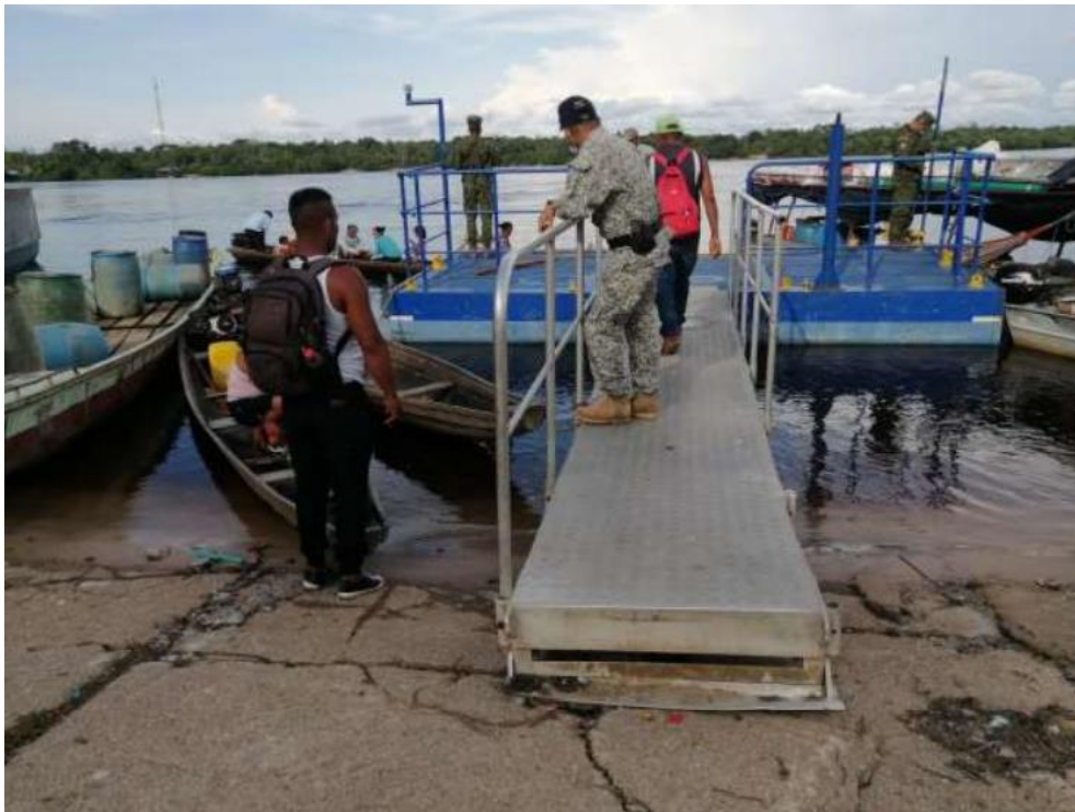
Ilustración 14. Muelle flotante Donado e instalado por DIMAR
