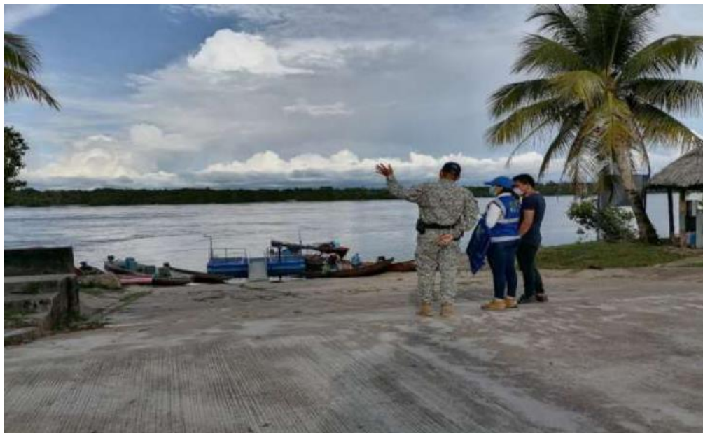
Ilustración 12. Muelle principal de San Felipe - inicia la rampa en concreto hasta llegar al Muelle que se observa al fondo de color azul con su pasarela lámina con barandas.
