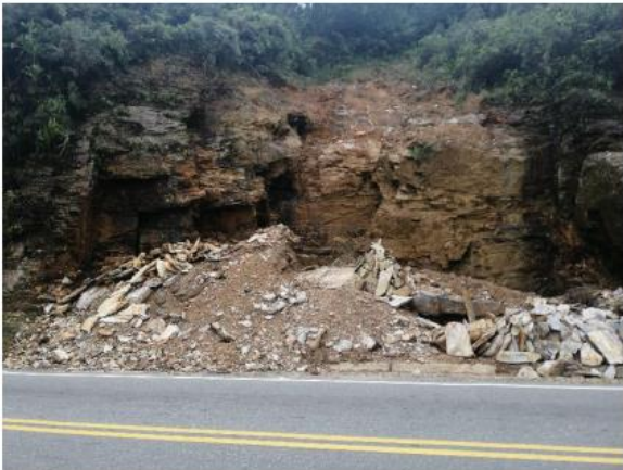
PUNTO 1 material extraído sobre la vía con taludes en contra pendiente de 2 a 4 metros de altura, se observan obstrucción a las cunetas viales Coordenadas al sistema MAGNA-SIRGAS Lat: 7.06441°N Lon: 75.44791°W
