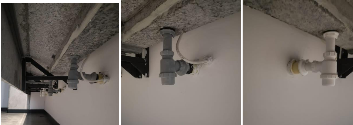
Ilustración 1. Revisión estado de tuberías y griferías
