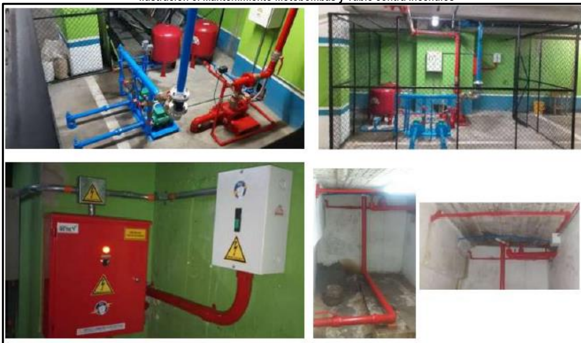
Ilustración 5. Mantenimiento Motobombas y Table contra incendios
