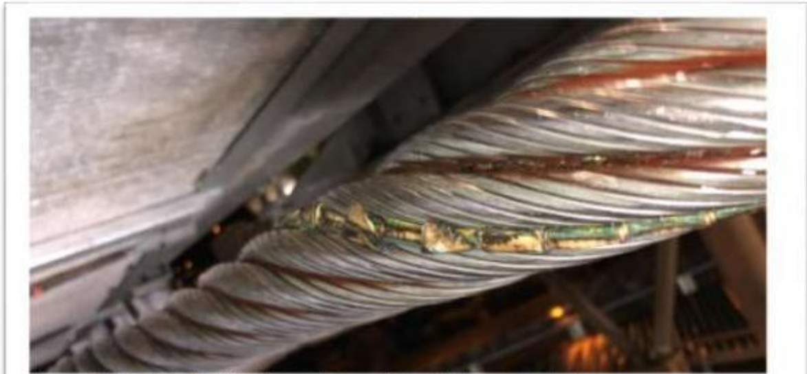
Fotografía 13. Salida de cintas de empalme por fuera del diámetro del cable.
